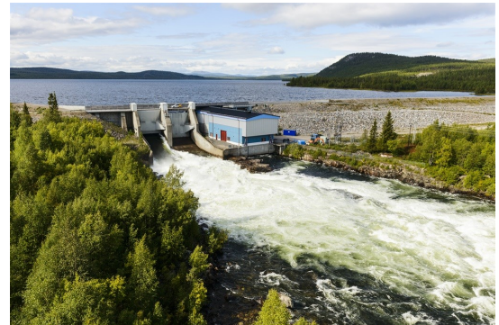
▲ Ett vattenkraftverk i norra Sverige
