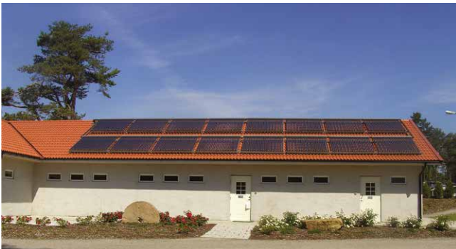
Solenergi. Solfångare på tak tar ingen extra yta. Utbyggnadsmöjligheterna är mycket stora.
