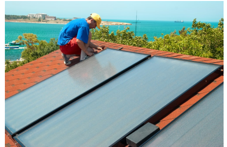
Solfångare monteras på hustak.
