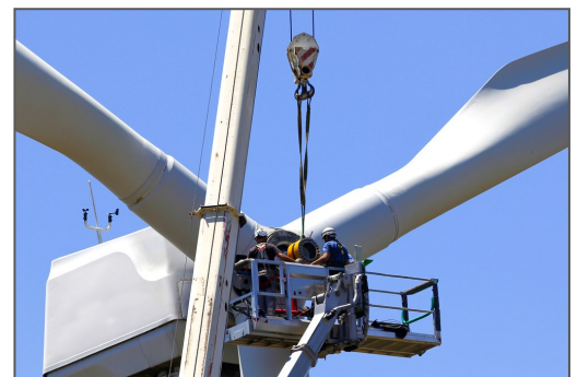
Rotorbladen på ett vindkraftverk repareras.
