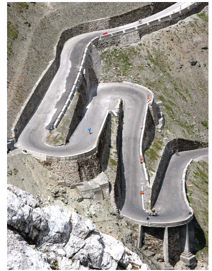
Serpentinvägar är ett bra exempel på lutande plan . Man får köra en längre sträcka, men samtidigt blir det inte en särskilt brant vägbana.
