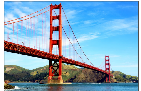
Golden Gate-bron i San Fransisco har pelare och kablar som håller upp körbanan.
