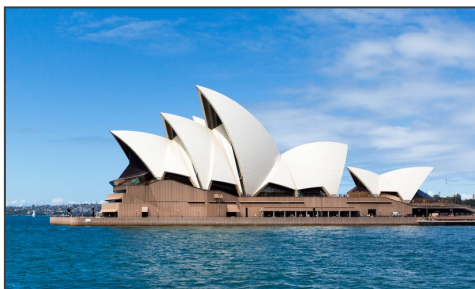
Operahuset i Sidney har betongvalv .
