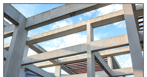
Balkar av armerad betong på högkant. Armerad betong är betong förstärkt med stålstänger.
