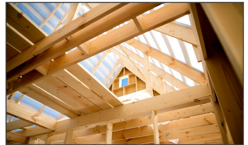
Balkar av trä brukar kallas för reglar och används på högkant.
