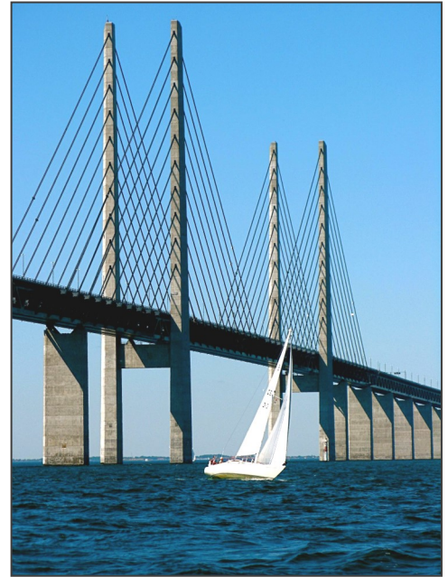
Öresundsbron måste vara beständig , alltså att materialen är motståndskraftiga mot olika väder och vindar.
