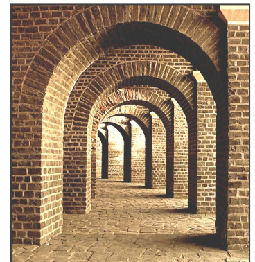
Valvbåge . Stenarna placerades i en båge , där stenarnas egen tyngd höll dem på plats, genom att stenarna pressades hårt mot varandra.
