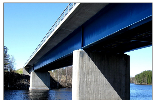
Brons konstruktion hålls uppe av I-balkar .
