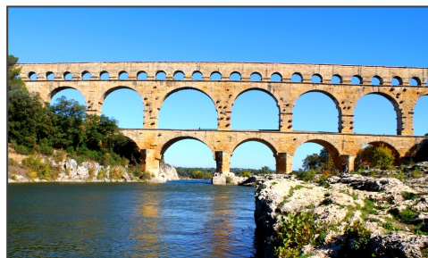
Romersk akvedukt med tre lager valvbågar
