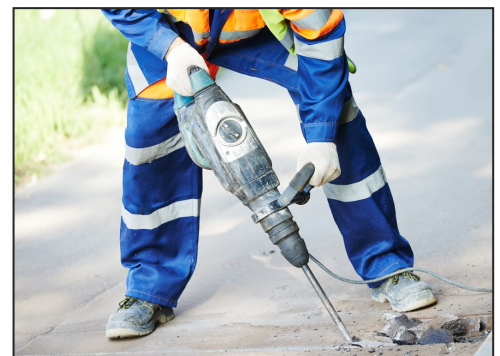
Arbete med en pneumatisk borr
